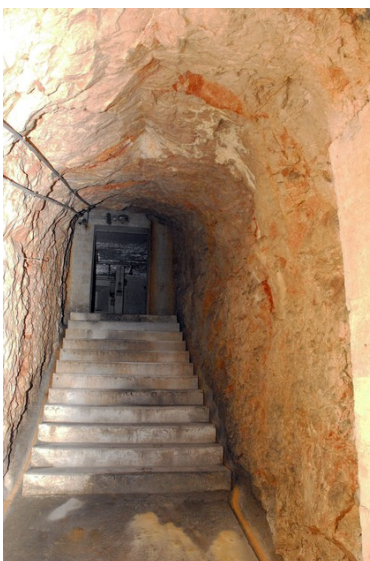
Aux Forges, les galeries ne sont pas bétonnées mais simplement creusées dans le rocher.
