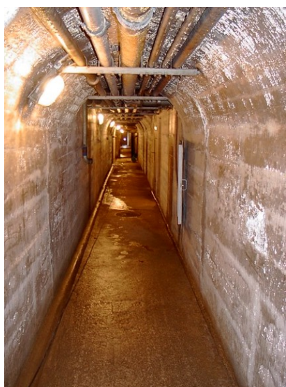
La galerie principale du Chételat d'une longueur de 55 mètres. L'épaisseur du béton et du rocher protège l'équipage contre les tirs d'armes lourdes et les bombardement aériens.
