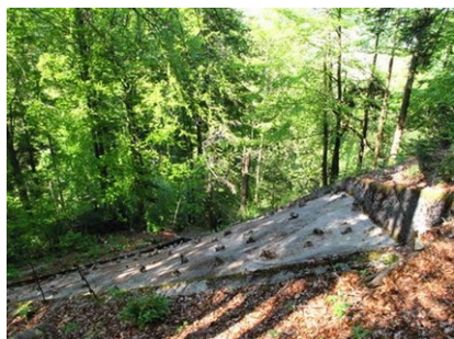
Une particularité de l'ouvrage du Chételat, du contre-ouvrage du Gy et d'un fortin d'infanterie du Vorbourg, c'est leur système de ravitaillement en eau. Comme il n'y a pas de source à proximité, une dalle recueille les eaux de pluie qui sont filtrées et stockées dans un réservoir.
