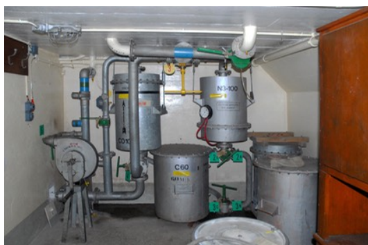
Un système simple mais efficace de filtration, de ventilation et de surpression empêche les gaz de combat de pénétrer dans l'ouvrage.
